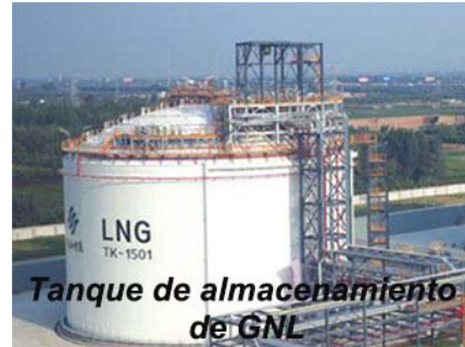
Cisterna de combustible
